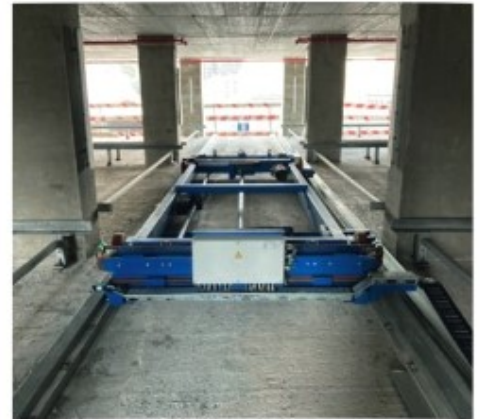
Blick auf das Shuttle während der Bauphase
